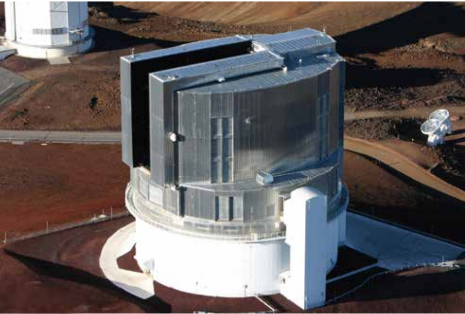
すばるの円筒型ドームは，マウナケア山頂に立ち並ぶ望遠鏡のなかでも特徴的です。水流実験，風洞実験，数値シミュレーションなどにより最良のドームの形を追求した結果，山頂尾根の端に設置するすばる望遠鏡には，円筒型のドームが適していることがわかりました。風通しのよいこのドームは，外部の乱流を含んだ空気をもち込まずに，内部の熱を効果的に排出することができます。望遠鏡そのものも熱を溜め込まず，まわりにも温度差が生じないようにすることで，鮮明な画像を得るために好都合な環境を維持しているのです。
